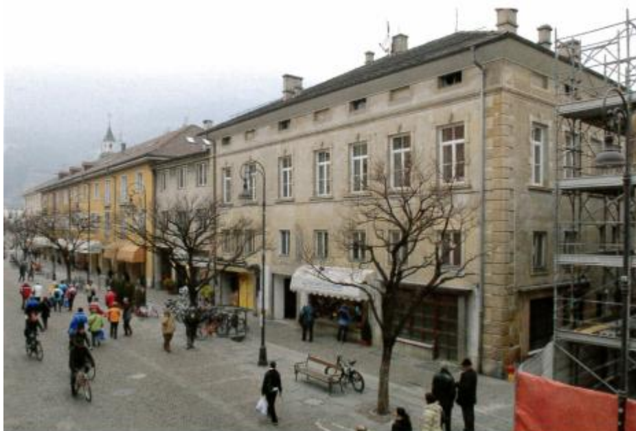
Milchzentrale in Brixen am Großen Graben vor dem Abriss 2007
