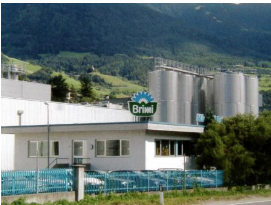
Betriebsgebäude in Vahrn vor dem Umbau
