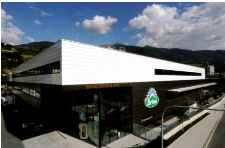
Der neue Milchhof Brixen nach dem Umbau
