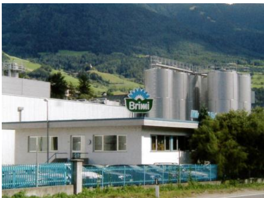
Betriebsgebäude in Vahrn vor dem Umbau
