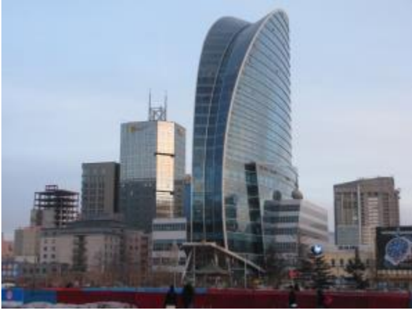
Hochhaus in Hauptstadt
