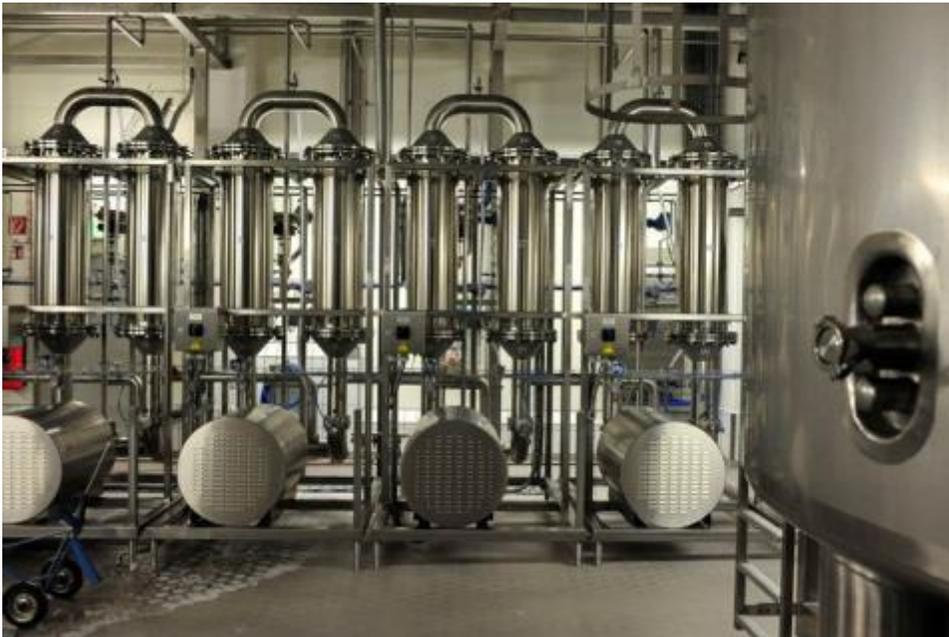
werden. Verschiedene Membranen wie die HpHT-Membranen, RO- und NF-Membranen von KMS sind gegenüber Oxidationsmitteln nicht stabil. Hier darf kein Chlor oder Aktivsauerstoff eingesetzt werden. Für andere Membranen ist eine maximale Chlor-Konzentration in ppm angegeben, die nicht überschritten werden darf.
