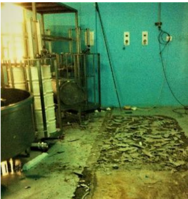
Vorbereitung zur Bodensanierung
